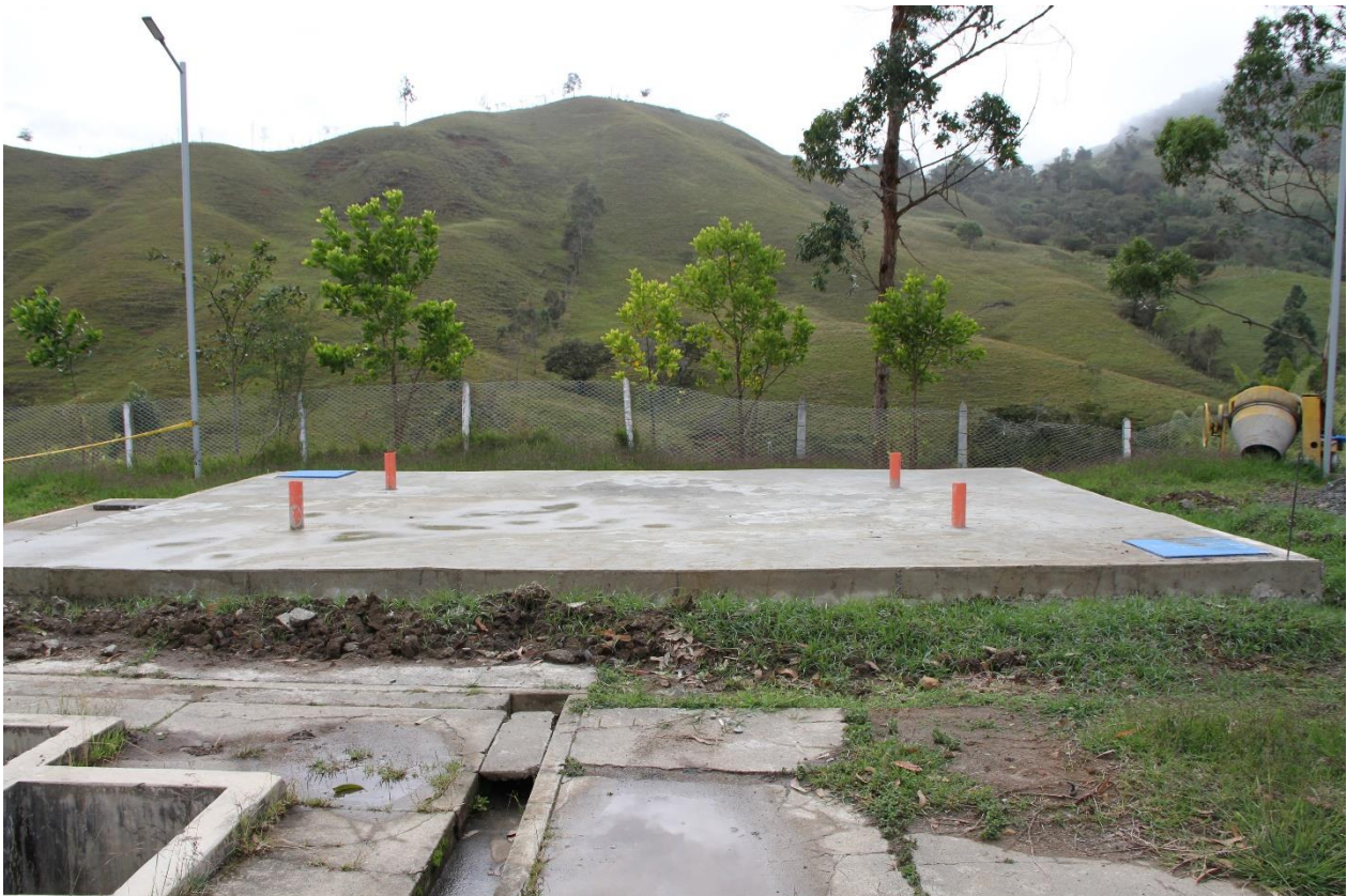
Foto /Vallecaucana de Aguas- Obra Acueducto, Corregimiento La Primavera- Bolívar
